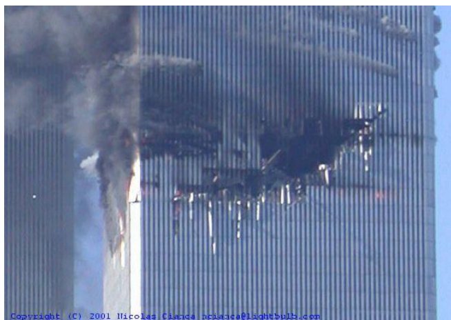
Rys. 14. Otwór wlotowy w wieży WTC1 odpowiada profilowi samolotu - skrzydła przecięły konstrukcję [27].
