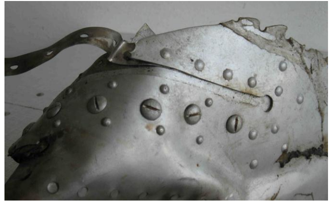
Rys. 34. Zbliżenie rezerowanego pęknięcia z podkładką i licznymi dodatkowymi nitami.
